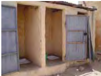
トイレの建設 (ケベメール県 Gueoul I)
