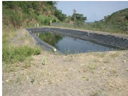
付写真 3-2-4 浸出水の溜池
