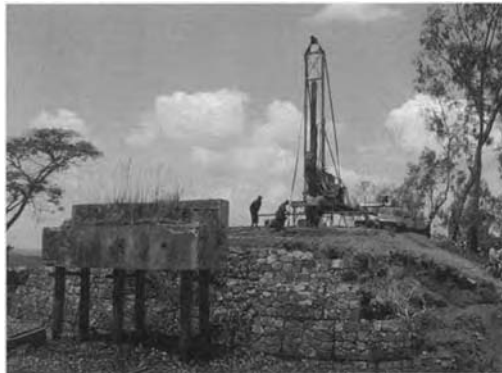
ラミロ側橋台(2003年3月撮影)
