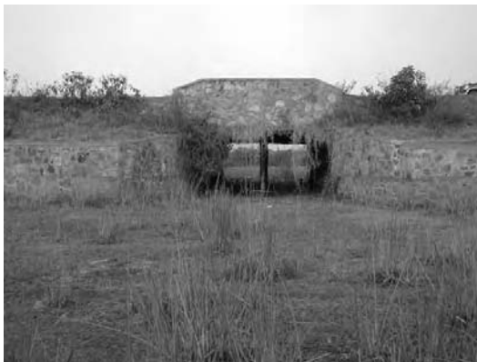
ガショラ2号橋上流側より望む
