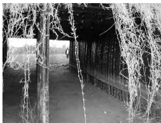
カルバート内の様子
