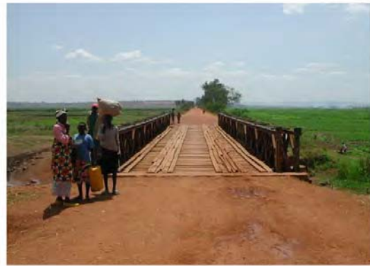
キブンゴ側アプローチ道路を望む
