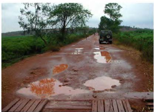
キブンゴ側アプローチ道路
