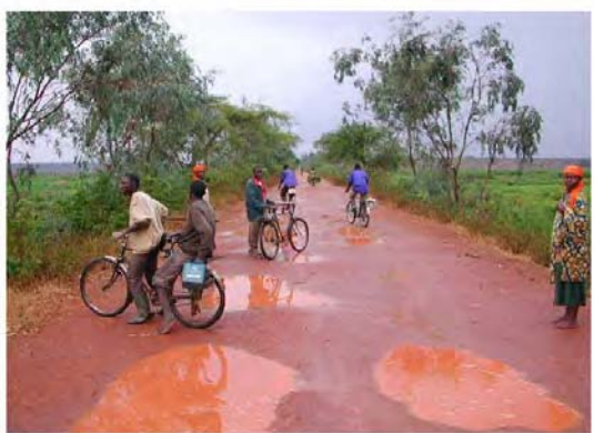
ラミロ側アプローチ道路
