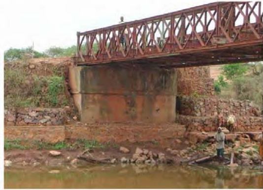
A1橋台正面
