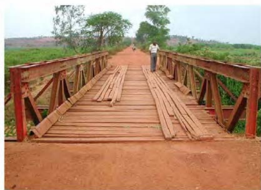
橋面の損傷
