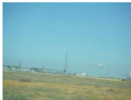
Факельная труба нефтегазового перерабатывающего завода
