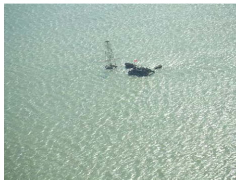
Работы по консервации заброшенной подводной скважины
