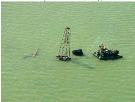
Работы по перекрытию подводной ликвидированной скважины
