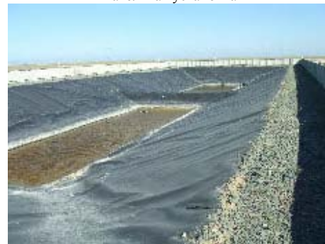
Строительство сооружений для ликвидации промышленных отходов
