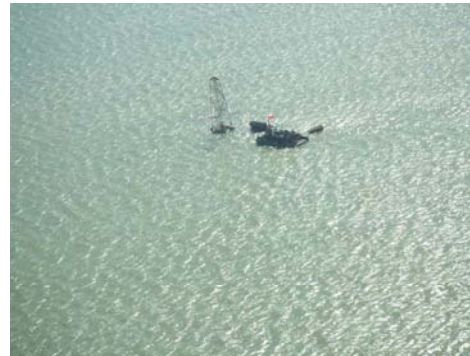
水没廃油井の閉止作業
