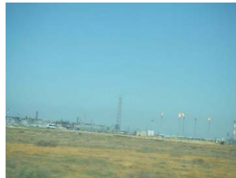
ガス精製所のフレアスタック
