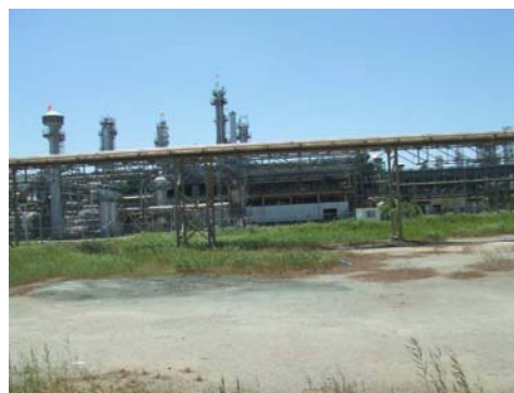
(ガス精製設備)
