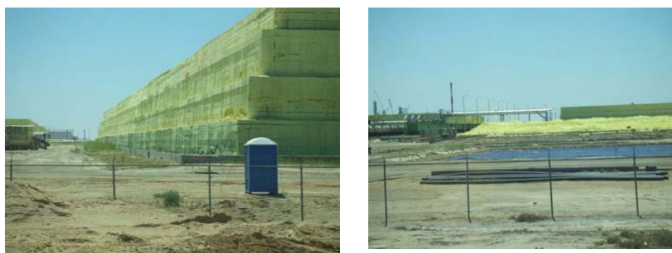
(ブロック硫黄の保管状況)
