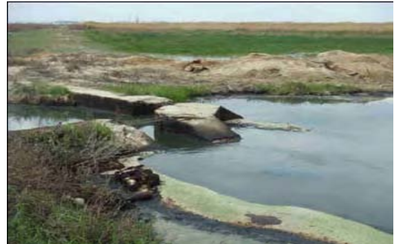
蒸発池での排水口
