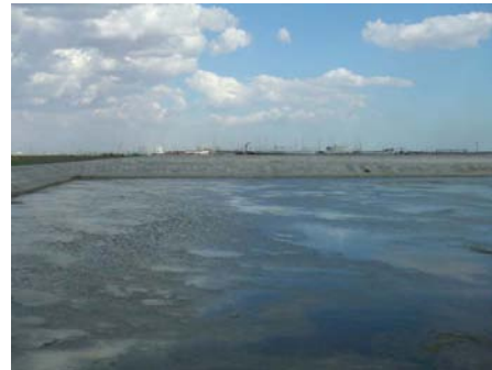
(排水処理 (蒸発池))
