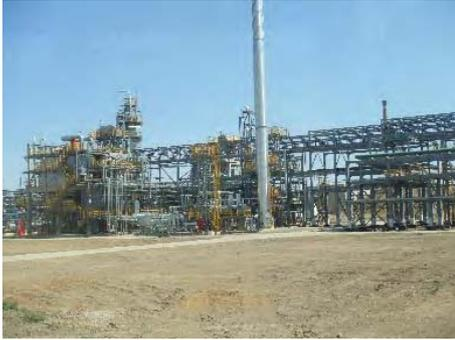
アティラウ製油所の脱硫装置
