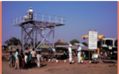
給水施設の建設現場。スーダンでは基礎インフラの整備が急務となっている(「ジュバ市内近郊地域緊急生活基盤整備計画調査」)
