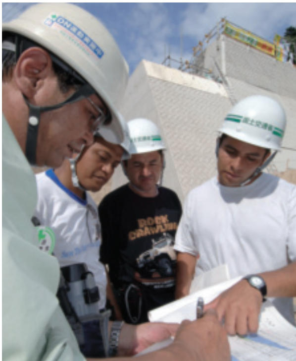
神戸市で建設中の砂防ダムを視察する研修員(JICA東京「火山学・総合土砂災害対策コース」) (撮影:今村健志朗)
