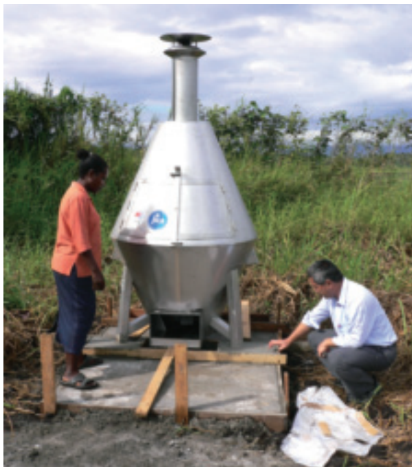
医療廃棄物からの感染を防ぐため、専用焼却炉を市街地から離れた場所に設置 (ソロモン「大洋州地域予防接種事業強化プロジェクト」)
