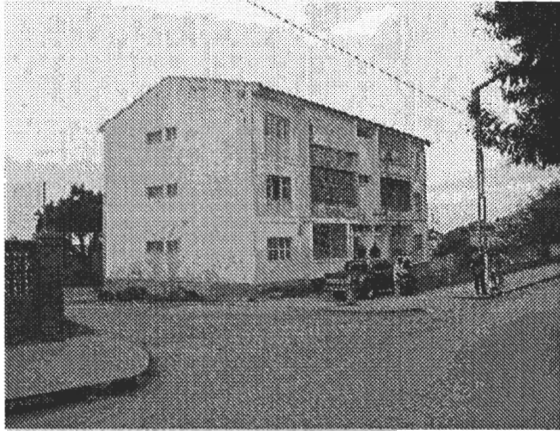
隊員ら居住のアパートの玄関側 隊員らは1階左側部分に居住している。
