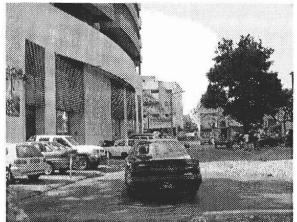
ビル裏側 別館部分で左の出入口部分が地下駐車場 出入口
