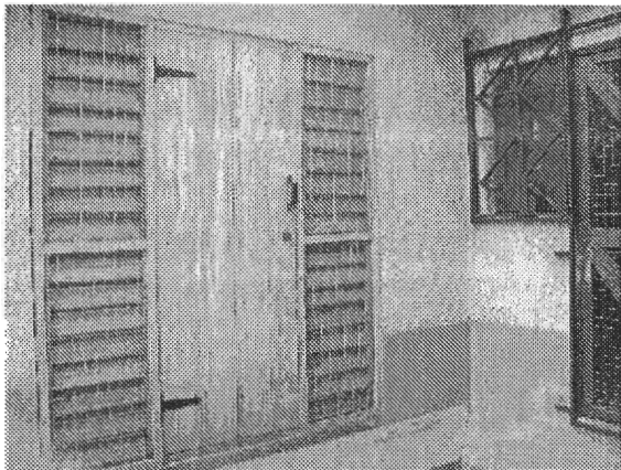
台所の出入口扉と窓 扉はシリンダー錠付きの板扉、窓はル ーバー板窓
