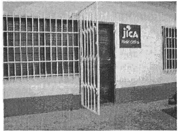
事務所玄関扉と窓
