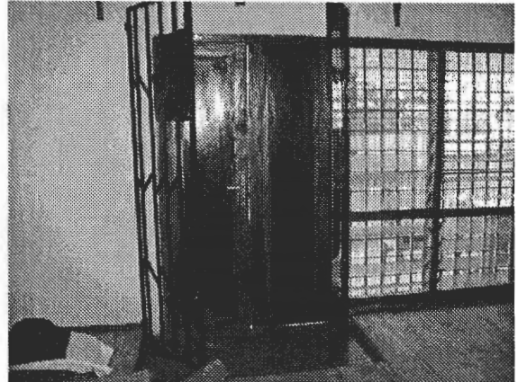
玄関扉の内側
