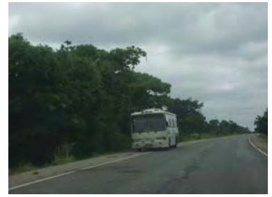
Sawla～Wa 間舗装道路
