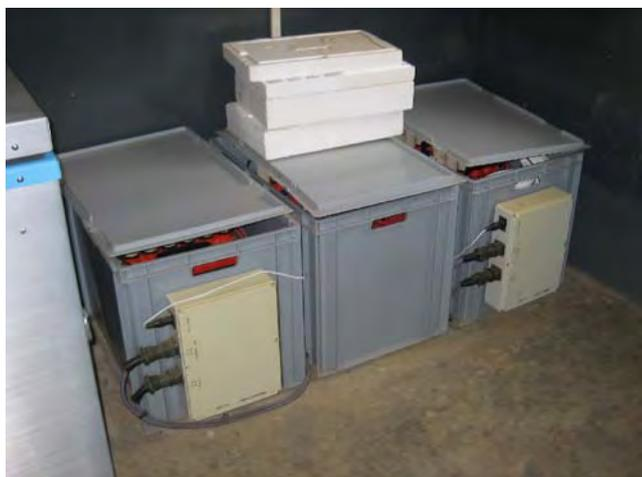
写真9 同保健センターで使用中のソーラー式冷蔵庫のバッテリー
