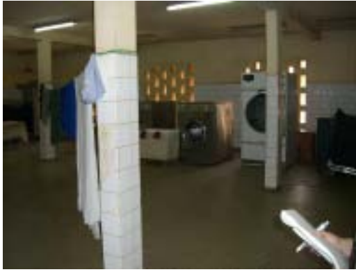
イサカガズビ産婦人科病院 サービス棟 ランドリー
