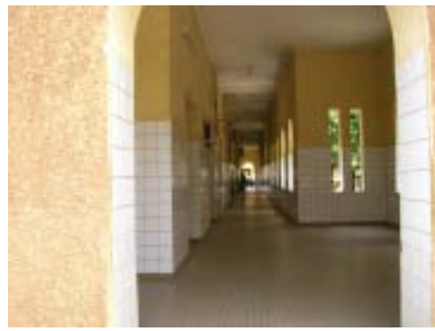
イサカガゾビ産婦人科病院 中央棟（歴史的建造物）外廊下
