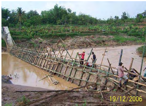
Pemasangan Jaring Sampah dari Bambu
