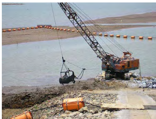
Penggalan Endapan Sedimen di intake Menggunakan Dragline, Oktober 2006
