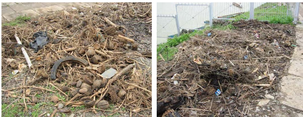
Foto: Pembuangan debris dan sampah di intake (29 Desember 2004)
