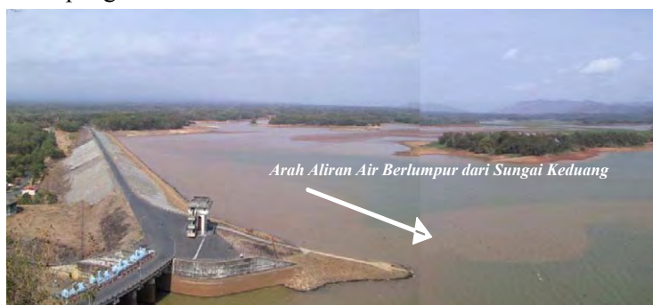
Foto: Arah Aliran Air Berlumpur dalam Waduk
