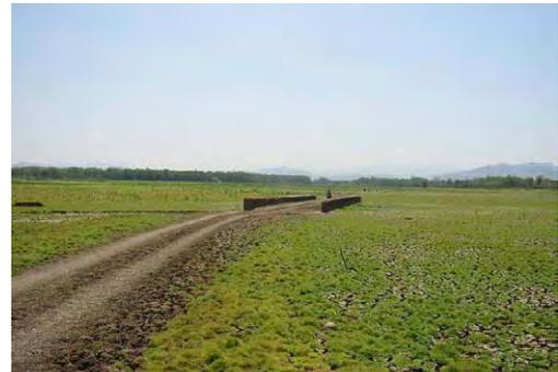
Endapan Sedimen pada jembatan lama pada lengan waduk di Sungai Alang
