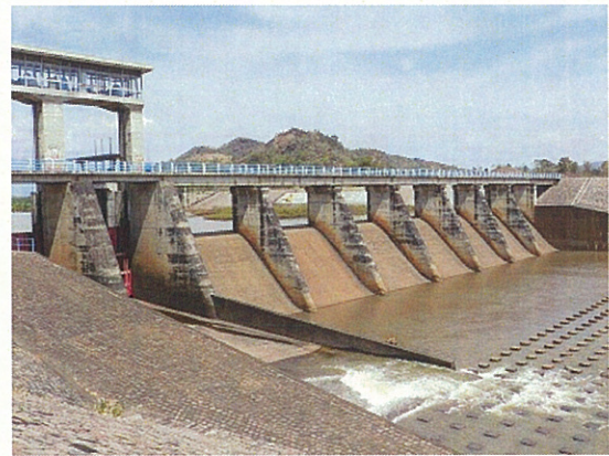
Pintu Pengambilan Bendung Colo
