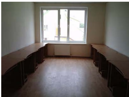
写真-7：同センター2階の教室。全5室あり、講義に使用される。照明は設置済みで使用可能な状態になっている。暖房機器も設置済み。
