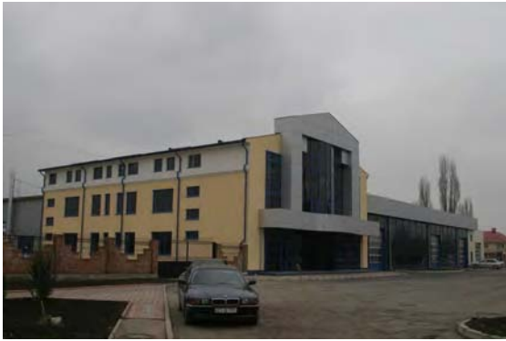
写真-1：国立農業機械化センター外観。手前（3階建て部分）が研修棟、奥の平屋（中2階もある）がワークショップ。
