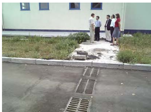
写真-6：同センターの油水分離設備。基本的な機能としては完成済みで、水再利用のためのポンプ等は今後「モ」国側が整備する。
