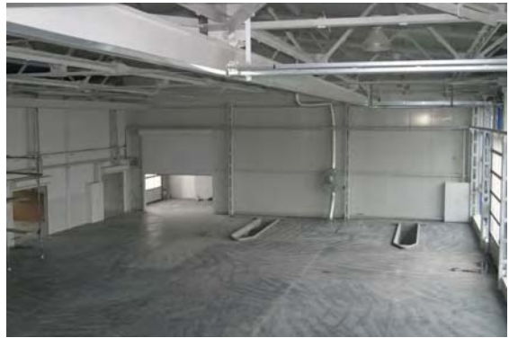
写真-2：同センターのワークショップ（修理作業室）。床は完成済みで重量のある計画機材の据付も可能。修理作業用のピット2カ所も完成済み。写真奥は機械洗浄室で完成済み。
