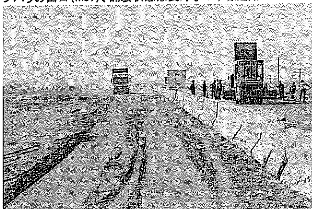
メンテナンス整備中の道路(4車線)(M37)
