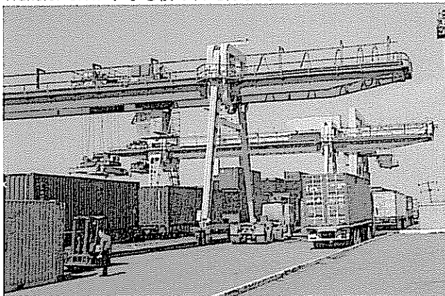
Transfer Crane (奥 35t、手前 25t)
