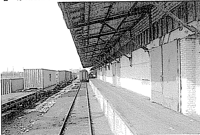
コンテナ貨車と倉庫
