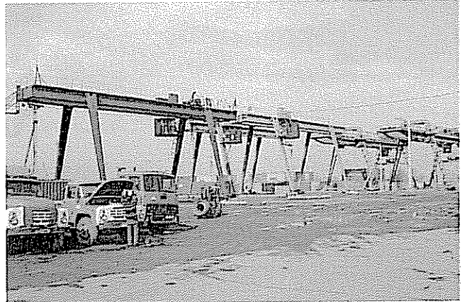
Transfer Crane (あまり稼働していない)
