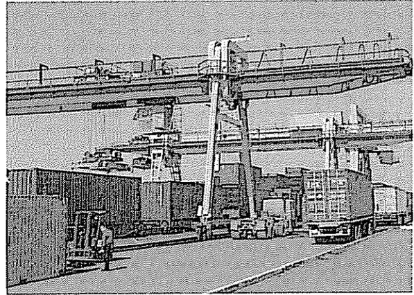
手前 25tonnes クレーン、左がコンテナ貨車、右トラック
