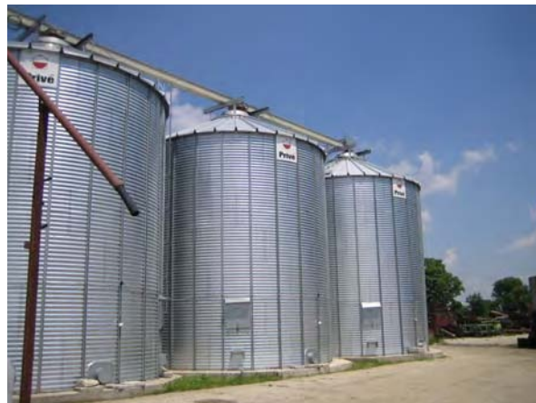
草の根無償資金協力により供与された穀物貯蔵庫
