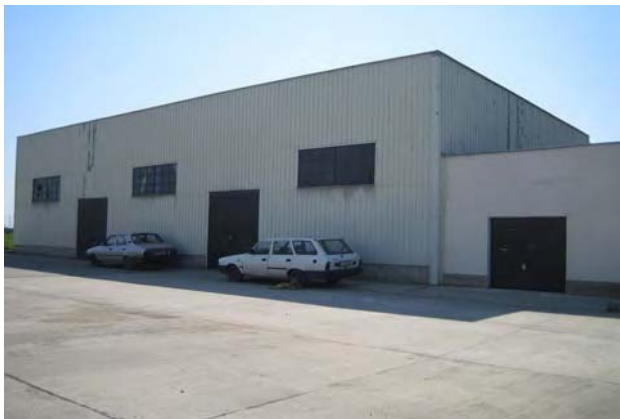
集出荷場（世界銀行・GTZの支援による）
