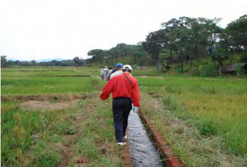
Nakahuga モデルサイト 農民により整備されたレンガ 積構造の用水路
