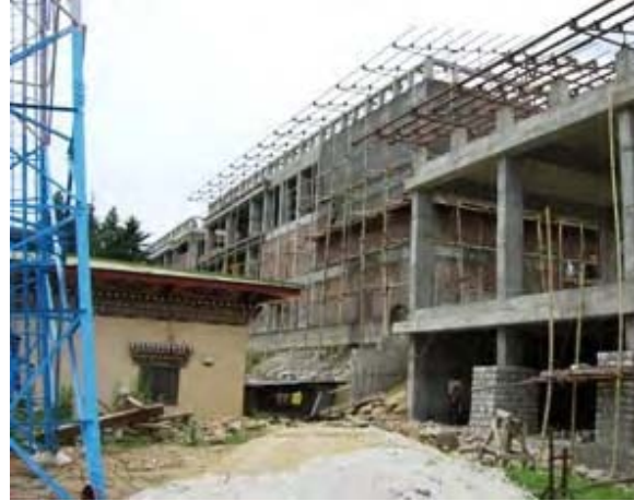
建設中の局舎
