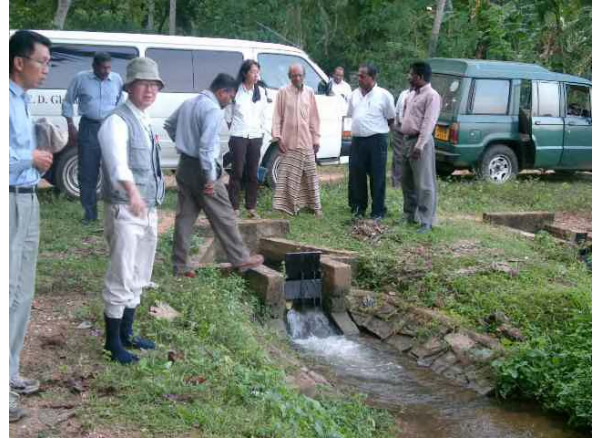
2. ラジャンガナ灌漑地区取水ゲート
