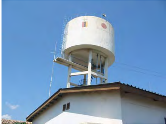
Unplanned settlement 給水高架タンク
