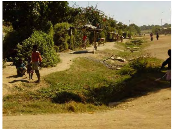
手掘り排水路
