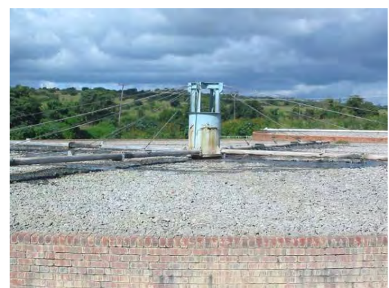
Garden 下水処理場—散水濾過方式 (機械設備は稼動していない)
