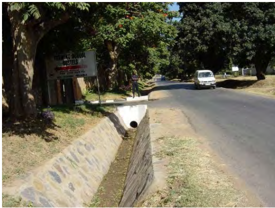
主要道路の排水路
