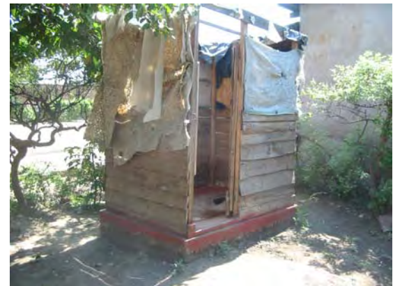
浸透性縦穴式便所（ピットラトリン）
