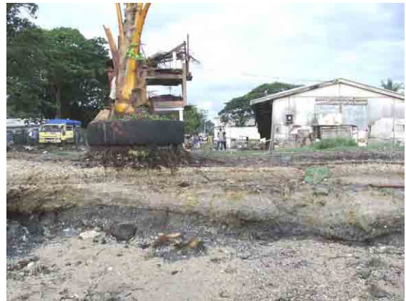
既存市場の海岸の浸食（奥は市場棟） 椰子の根元まで潜掘されている。
