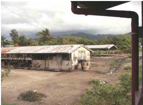
既存市場棟（右手が海岸） 高潮時には壁で囲まれた部分（キオスク：軽食・飲み物販売所）の中ほどまで浸水する
