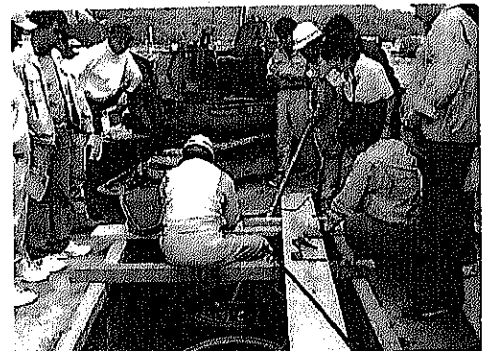
課種別研修:「集合処理(下水道など)と個別処理による生活排水処理計画」コース研修員による浄化槽の視察
