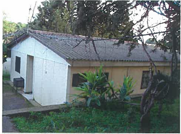
中央地方研究室管理棟
