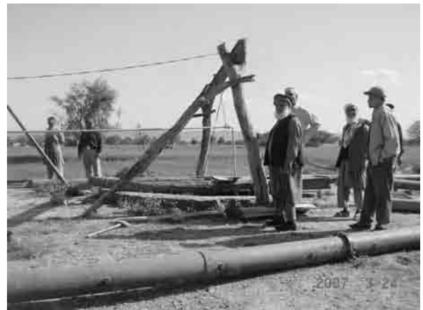
コハット県ラチ町の水源地の手掘り浅井戸（浅井戸3）の状況、12年間で地下水位が24m下がっているという
