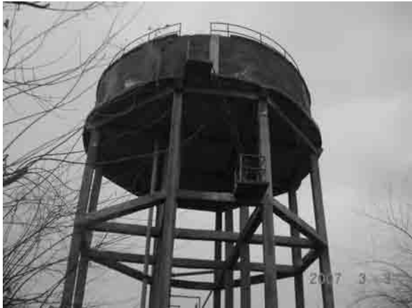
コハット県 Mohammed Zai の 1980 年代に建設された高架水槽、漏水あり
