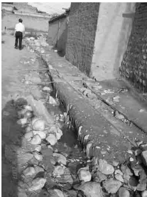
カラック県・Teri 村の村落内の給水パイプ網。村落内には廃水がそのまま垂れ流される
