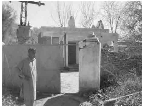
コハット県 Kohati Dhoke 村の水源井戸、1980 年に建設された古い井戸で揚水効率が落ちているという
