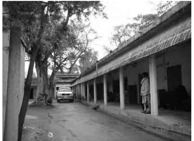
コハット県・WSSD（給水・衛生課-県公共事業部）の古い建物で事務機器も年代ものが多い
