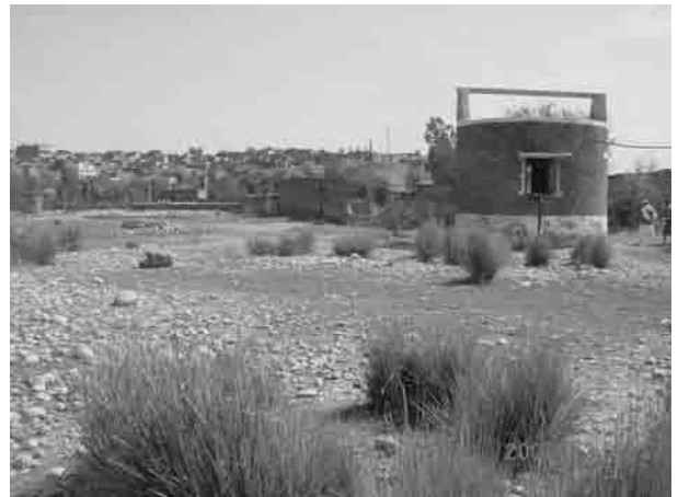
カラック県 B. D. Sshah テシルの Teri 村の水源である河川敷の大口径浅井戸、後ろが丘の上に広がる Teri 村
