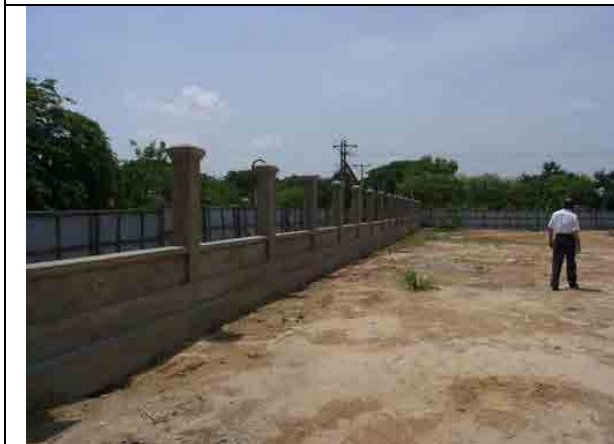
フェンス工事 (鉄柵は 2008 年度工事)
