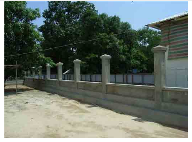
フェンス工事 (鉄柵は 2008 年度工事)
