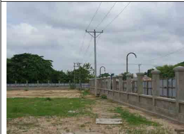
移設予定の北側電柱
