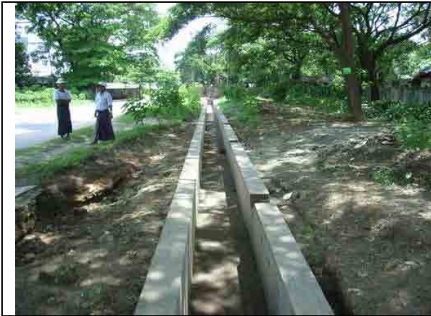
建設予定地北西の側溝（ミ国側工事完了）
