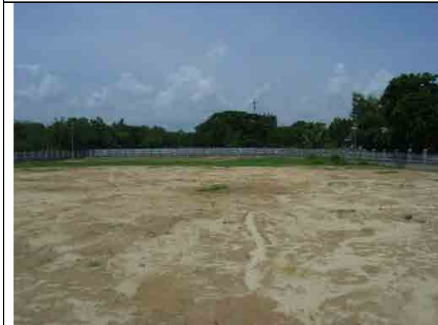
建設予定地の東を望む (ミ国側造成工事完了)
