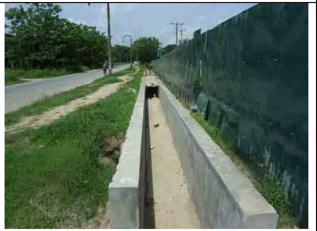
敷地北側側溝工事（ほぼ完了）
