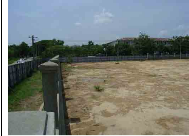
建設予定地の北西を望む (ミ国側造成工事完了)
