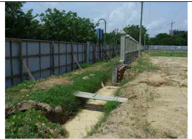
フェンス工事 (ゲート部分は未完)
