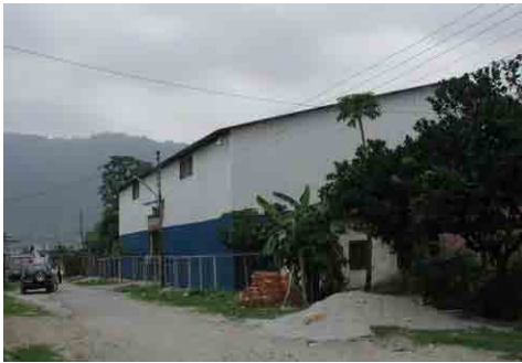
集出荷倉庫外観
