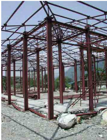
鉄骨造多目的ホール（Phuentsholing HSS）
