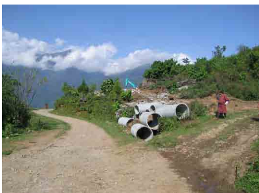
仮設道路入り口（右側がサイト）
