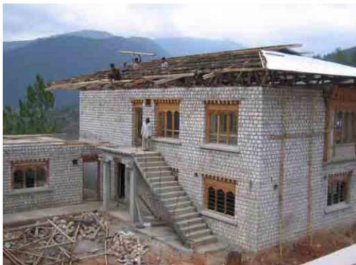
実験室・図書室棟 木製屋根下地の工事
