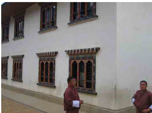
6教室棟の裏側
