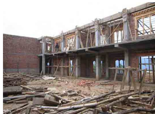
多目的ホールの内部
