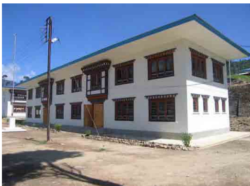
管理・図書室棟 きれいに仕上がっている外壁
