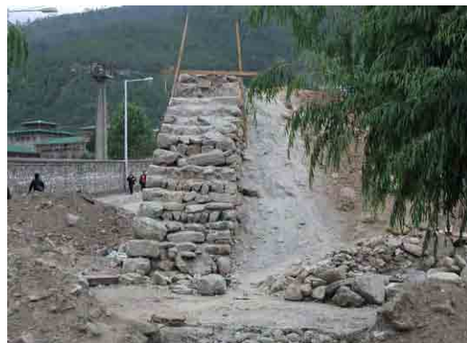
擁壁工事（ティンブー）
