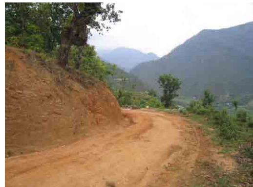
整備途中の工事用道路（工事が中断）
