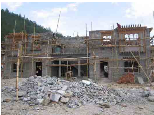
管理棟外観 石積みの外壁、木製装飾部分の工事
