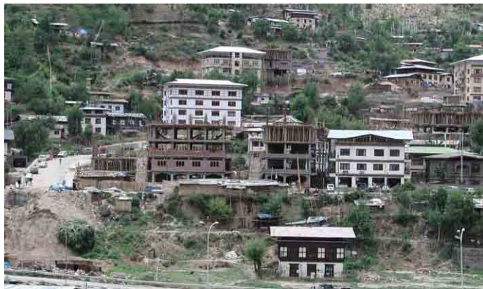
ティンブー市内は建設ラッシュである RC造が工法の主力となっている
