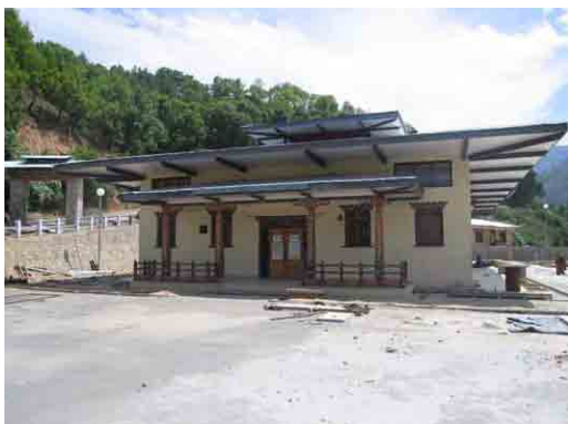
多目的ホール（鉄骨造）
