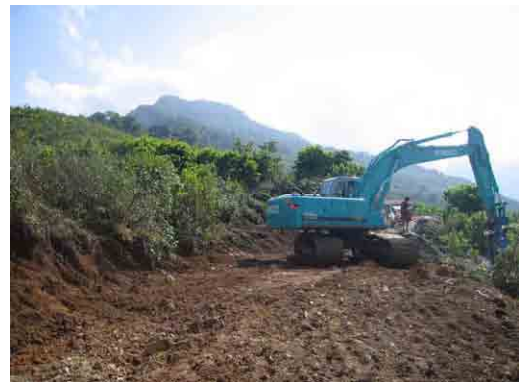
工事中の建設機械
