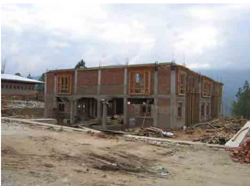
多目的ホール外観（RC造）
