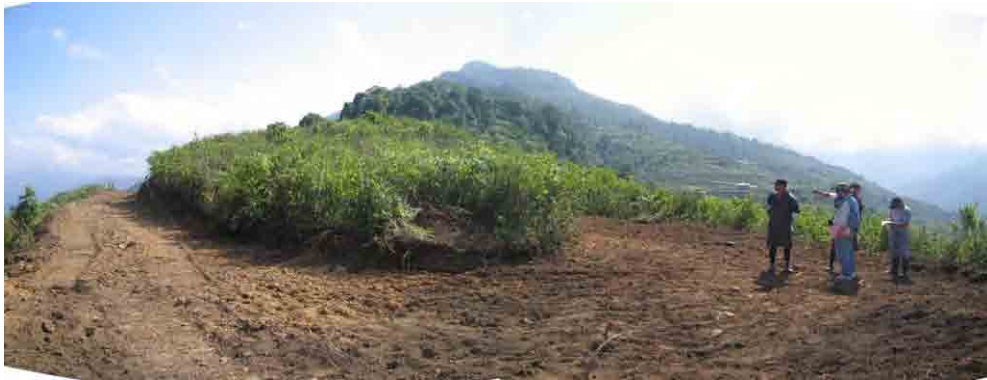
敷地 中央付近の尾根が宿泊施設ゾーン予定地
