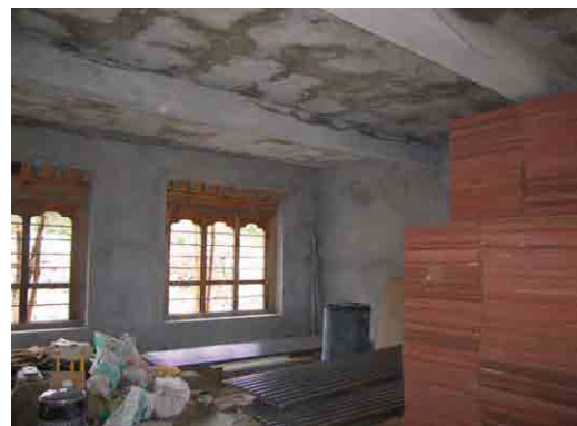
管理棟内部 天井スラブはRC造
