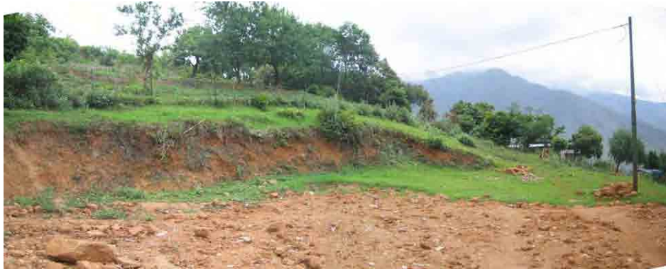
敷地中腹 計画敷地内の既存校舎は撤去済み
