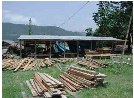
現場搬入木材：現場での建具加工が多いが、乾燥が不足している
