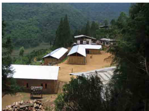
現在利用している仮設教室棟 グラウンドを使用して建設
