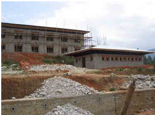
6教室棟、手前がトイレ棟
