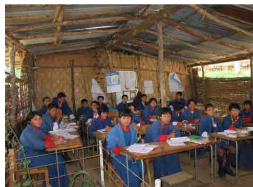
仮設教室内部 竹製の外壁で、簡易な建物
