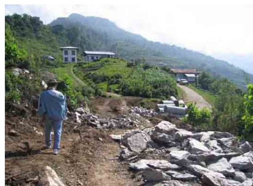
仮設道路から既存道路を望む
