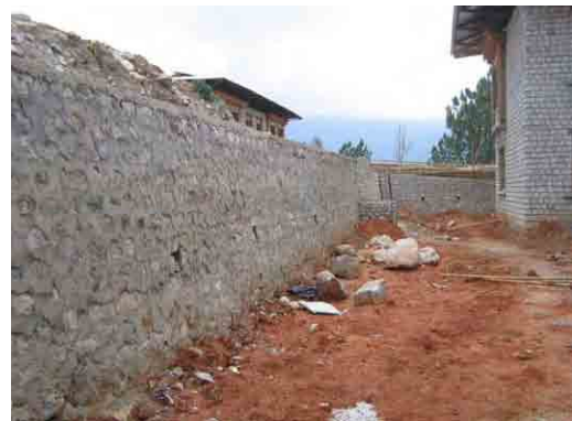
石積み造の擁壁
