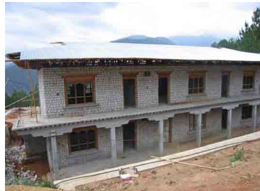
6教室棟外観 廊下側から望む
