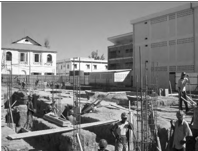
コンクリート打設は、一輪車を使用してシュート上に落とし周囲の作業員が直ちに均し、最後に左官職が押えを行う段取りで工事を行っている。
