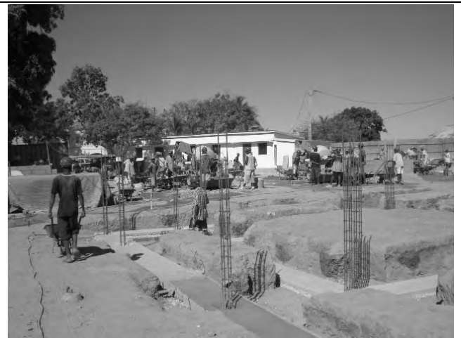
現場の地質は、ラテライトであり、根伐はすべて人力により実施されている。
