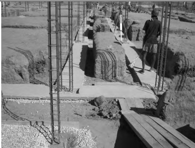
捨てコンクリートの打設後の状況、トランシットを設置して通り芯とレベルを設定している。
