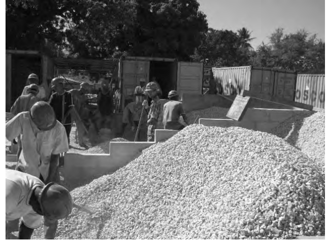
骨材集積場は C.B で仕切られ管理されている、後方に見えるコンテナには、セメントと鉄筋等が収納されている。
