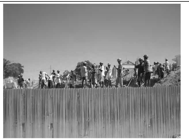
根伐土処理に雇用されている労務者、ほぼ人海戦術で作業が行われていて建設機械は見られない。全作業員ヘルメット着用して作業を行っている
