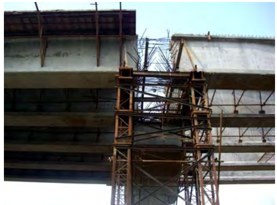
工事中の高架道路
