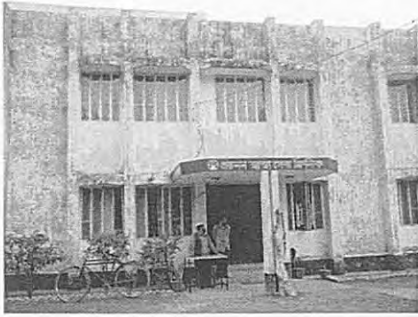
草の根無償資金協力によって建設された 多目的女性研修センター、パンチドナ地区
