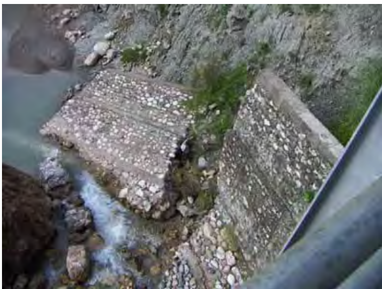
水路橋橋台を保護する石積護岸工： STA .0+ 780
