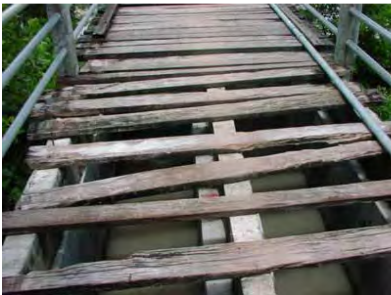
水路橋上:STA. 0+ 780
