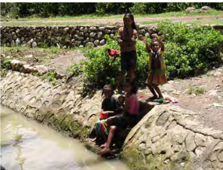
ラマスコラ 2 次水路：STA.0 + 050 付近
