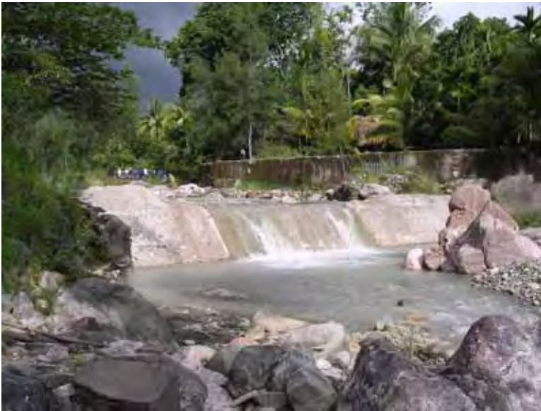
マリアナ I 取水施設固定堰本体： (右岸下流側より)
