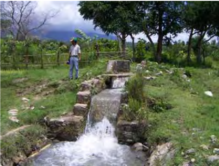
リタバウ 2次水路：STA.0+210
