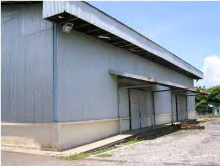
MAFF ボボナロ県農業事務所敷地内の貯蔵倉庫（背面）
