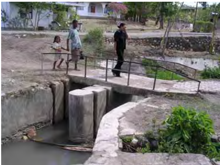
幹線水路から2次水路の分水地点： STA.1+ 530
