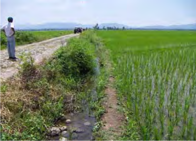
リタバウ 2次水路：STA.3+900
