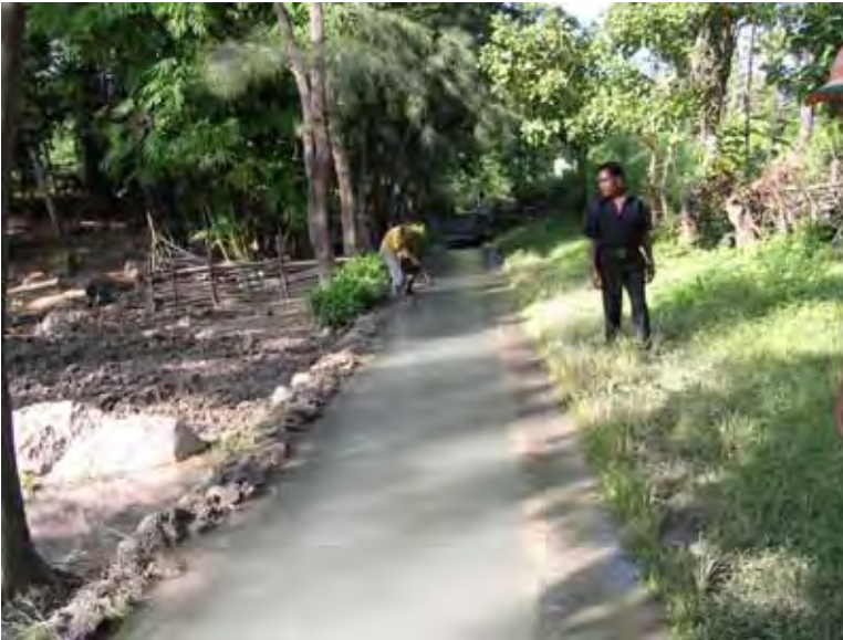
幹線水路：STA.0+660 フルーム水路
