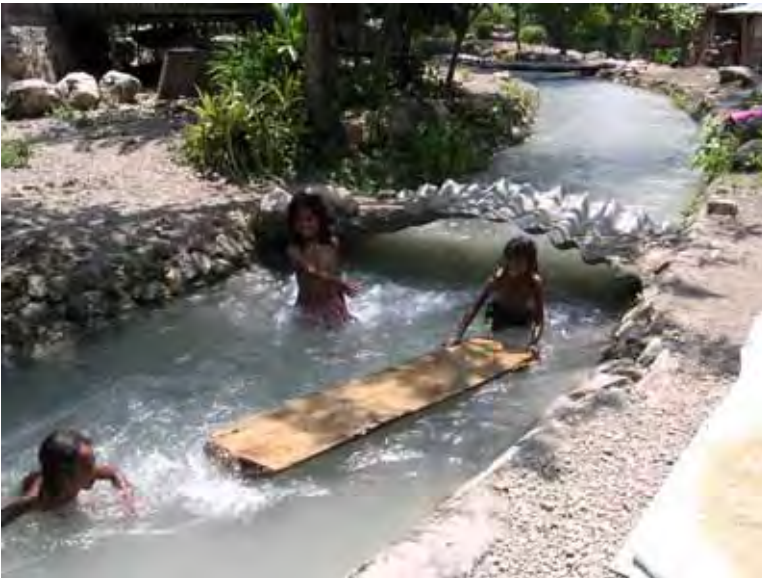
幹線水路：STA.0+900 付近
