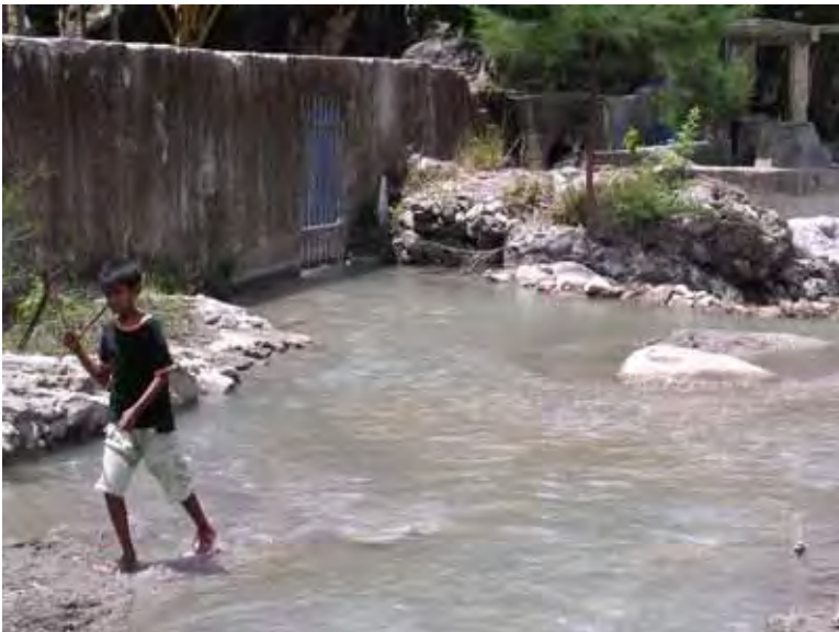
導流部および取水口スクリーン：
