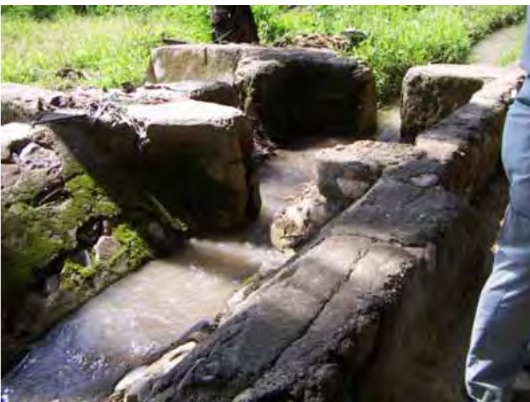
リタバウ 2次水路：STA.4+770
