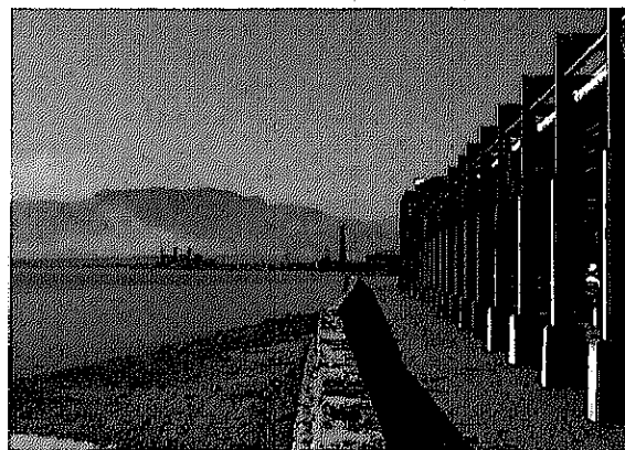
Ce complexe pétrochimique (à l'arrière-plan) est considéré comme l'un des pollueurs du canal de Suez ; ce projet comporte également des mesures de lutte contre les rejets d'hydrocarbures dans le canal.
