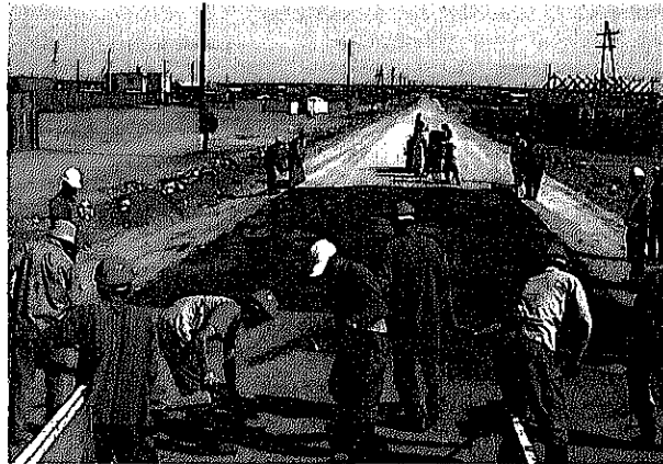
Asphaltage d'une route communautaire dans le cadre d'un programme de partenariat de la JICA impliquant la participation des résidents locaux (développement du cadre de vie dans le district de Baganuur en Mongolie)
