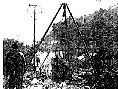
Sondage exploratoire pour la reconstruction d'un pont
