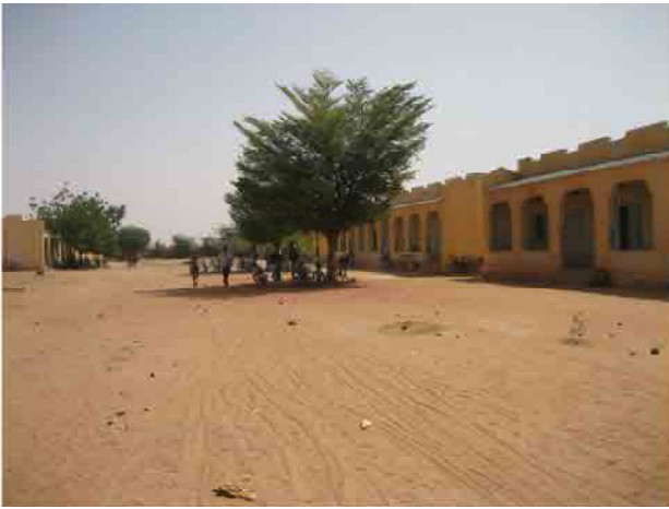
Vue générale, la cour intérieure et les bâtiments de salles de classe
