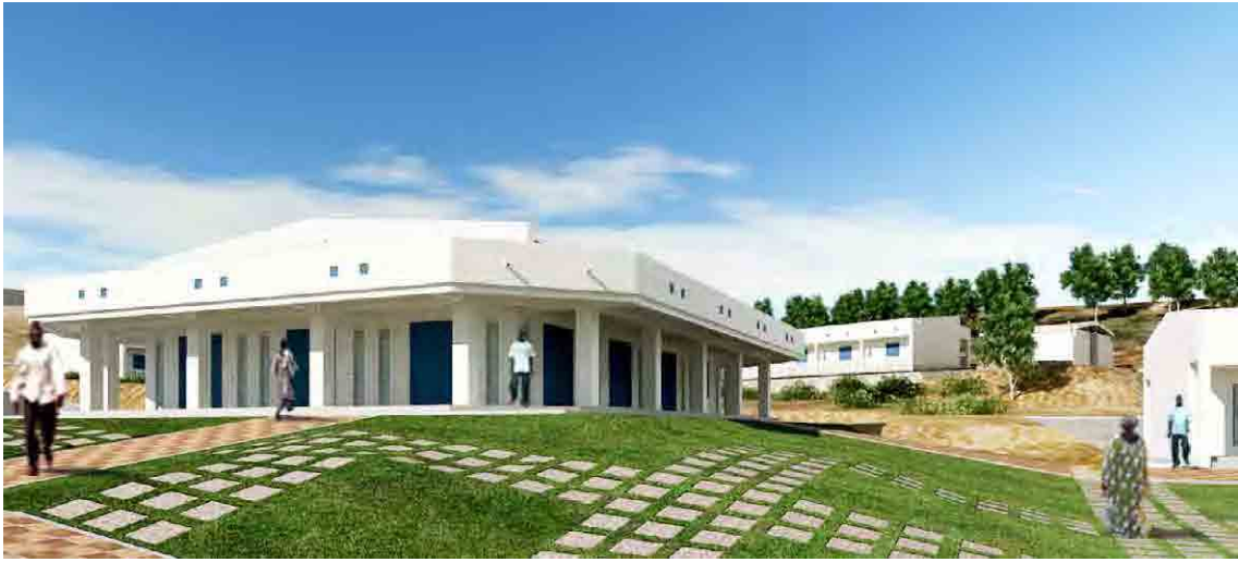
Bâtiment du Hall Polyvalent
