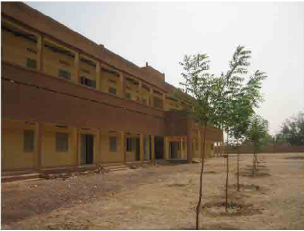
Vue générale-1, bâtiment des salles de classe
