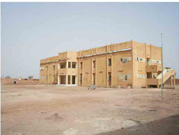
Bâtiment du Dortoir
