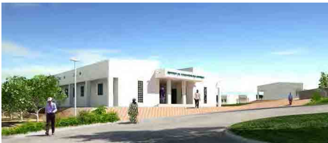
Entrée principale du bâtiment d'administration
