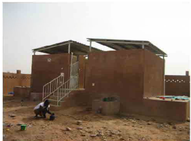
Les latrines pour usage des étudiants du dortoir.
