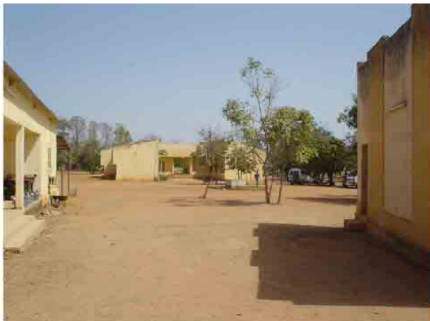
La cour intérieure et façade du bâtiment des salles de classe.
