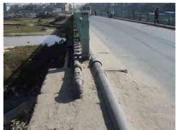
既存マノハラ橋の橋面状況 高欄、舗装等を修理して継続使用する
