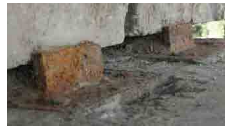
写真 2-11 既存橋梁の支承
