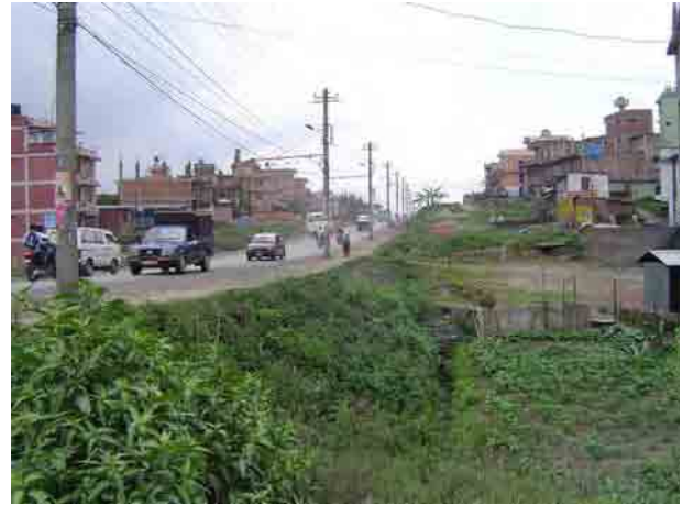
ガタガール付近の道路縦断が凹型で洪水時に冠水する場所
