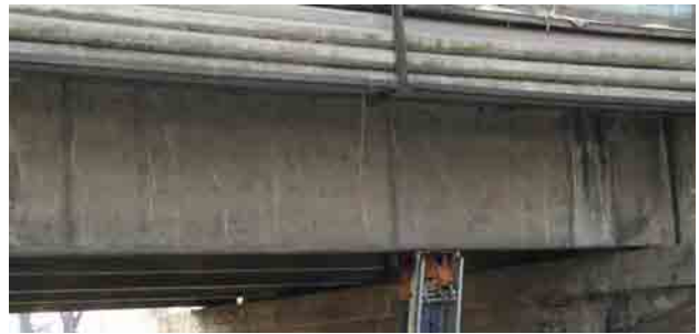
写真 2-10 既存橋梁の外桁
