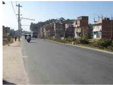
写真 2-7 ティミ～ハヌマンテ橋に至る区間の状況
