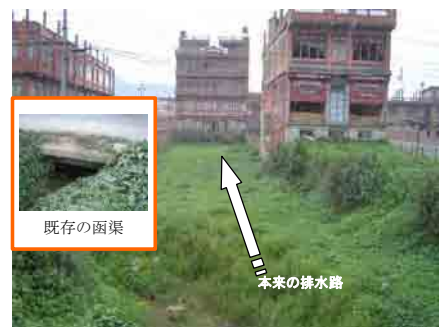
写真 2-8 排水先が閉塞されている状況
