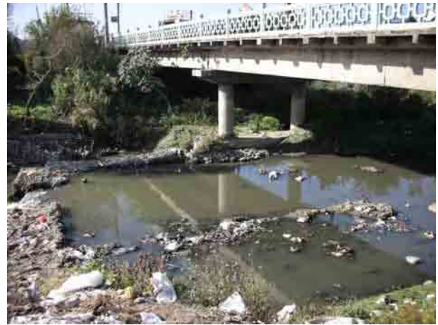
既存ハヌマンテ橋
