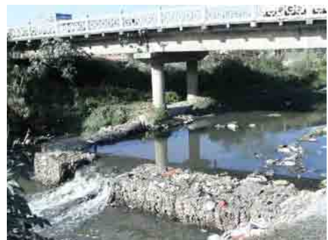
写真 2-14 既存ハヌマンテ橋の護床工
