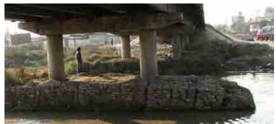
写真 2-12 既存マノハラ橋の洗掘防止工
