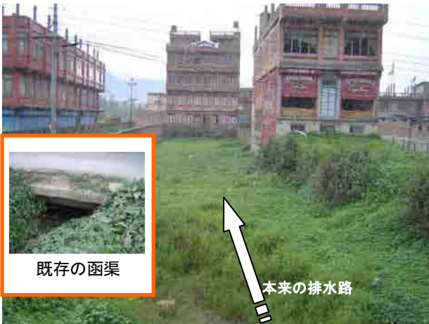
ティミとハヌマンテ橋の間にある既存の涵渠の排水路は建物で流路を阻害されている
