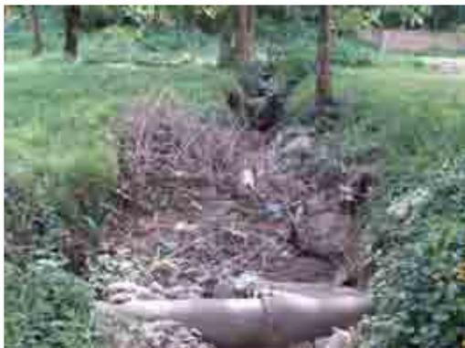
写真-2.7 流末の状況。横断管や堆積物が阻害して、処理能力が失われている。
