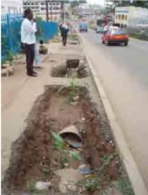
写真-2.5 歩道の下に排水パイプが埋設されていたが、清掃ができないため、掘り起こして開水路にして管理している。
