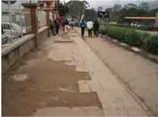
写真-2.16 コンクリートパネルの破損が目立つ
