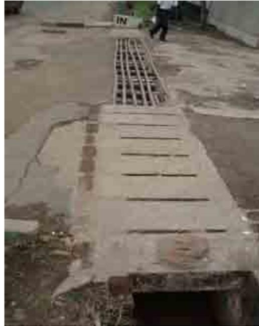
写真-2.6 奥のグレーチングタイプのふたは水をよく吞めるが取り外しができないので、清掃が困難である。手前のタイプはふたがはずせるので清掃が容易である。
