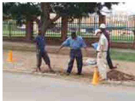
写真-2.20 土質試験用サンプルの収集状況
