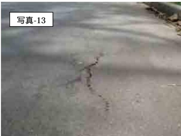
工業地域に位置するマカタ道路の状況。施工して一年であるが、早くも舗装ひび割れが見える。ひび割れ幅が10mm以上で下の路盤材が見えている。
