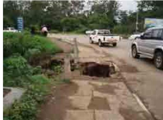
写真-2.17 地中でパイプが漏水したために歩道とともに崩壊した例。
