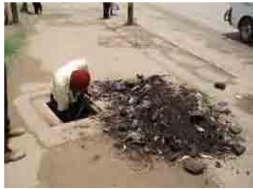
写真-2.4 人力による集水ますの清掃状況
