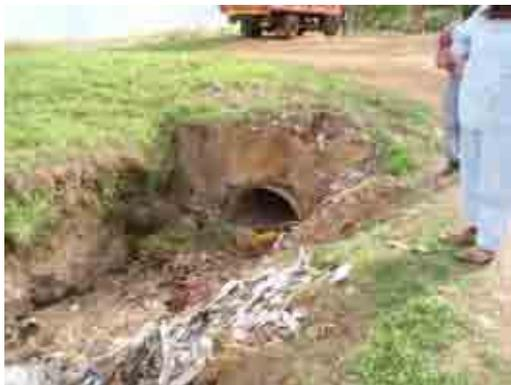
写真-2.3 横断側溝のはけ口。清掃ができなため土砂が堆積し、側溝が十分に機能していない。
