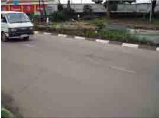
写真-2.1 チペンベレ道路の現況舗装。舗装全体にひび割れが発生している。
