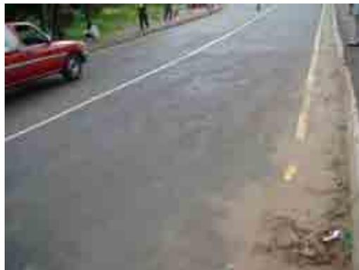
写真-2.25 ケンヤッタ道路の表層剥がれ。表層シール工で施工されているが、交通荷重に耐え切れなくなっている。
