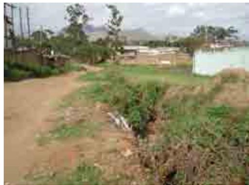
写真-2.8 流末部の排水側溝。のり面が崩れて土砂が入り込んでいる上、植生が覆っており、処理能力が失われている。
