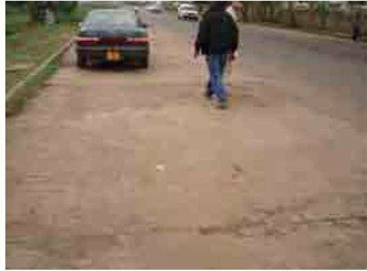
写真-2.2 バス停留所の舗装状況。コンクリート舗装されているが、鉄筋による補強がされていないためにひび割れが著しい。
