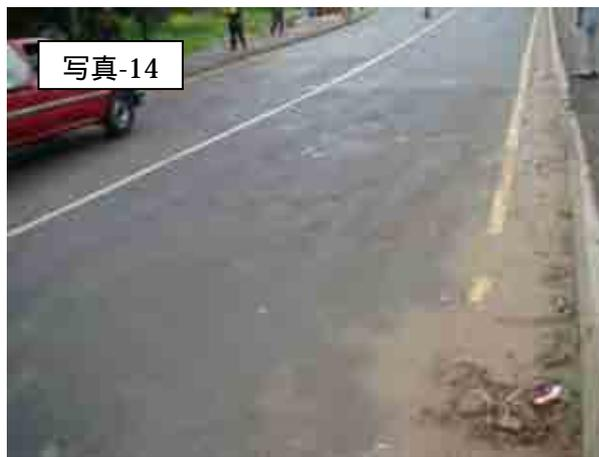
今回整備対象路線のチペンベレ道路と並行しているケンヤッタ道路の整備状況。施工して一年であるが、表層の剥がれが見える。
