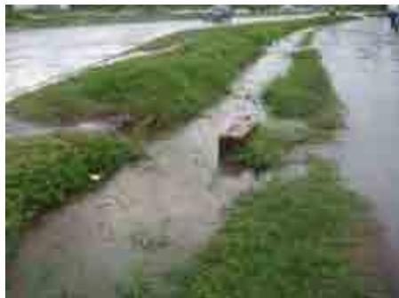
写真-2.9 トヨタ・マラウイ前の排水状況。ボックスカルバートが機能していないため、道路に逆流している。
