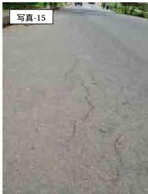
写真-13と同じマカタ道路の別の箇所の状況。同じように道路の舗装ひび割れが生じている。わだち掘れもうっすらとみられ、大型車による影響と舗装厚の不足が原因と考えられる。
