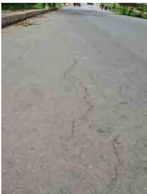
写真-2.23 マカタ道路の舗装ひび割れ。舗装厚不足による舗装破壊と思われる。
