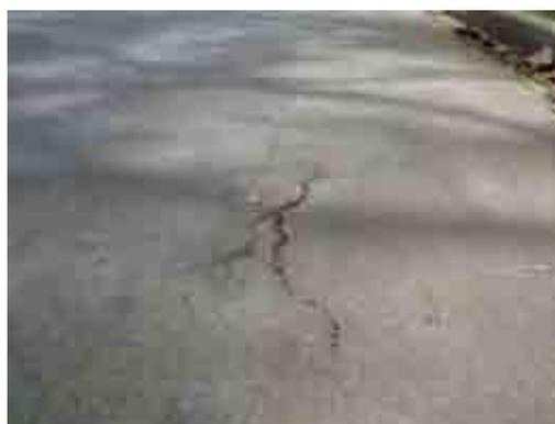
写真-2.24 マカタ道路の舗装ひび割れ。ひび割れ幅が 10mm 以上で下の路盤材が見えている。
