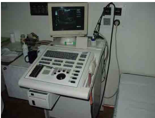
写真-11：外来 1F 超音波室の日本製超音波診断装置（1980 年製）。プローブの断線があり、画像が不鮮明である。また操作盤のトラックボールが作動しない。当該製品/プローブは製造中止で部品の調達が可能
