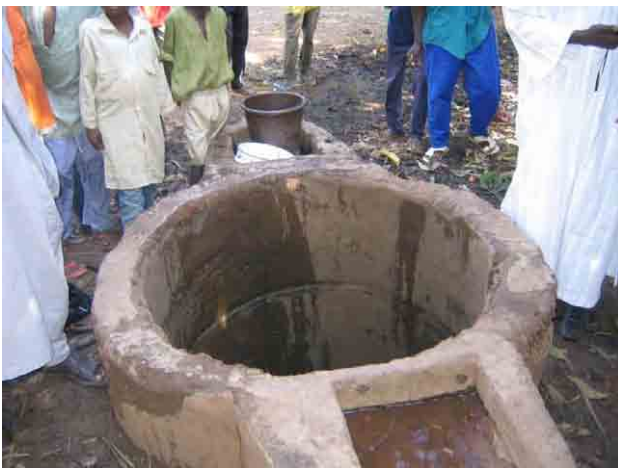
ダマツル郡管轄のセメント井戸給水施設
