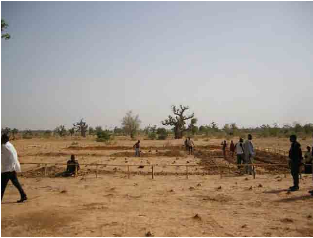
新庁舎建設現場と同じ敷地内での新倉庫・ 機材修理工場建屋の建設工事
