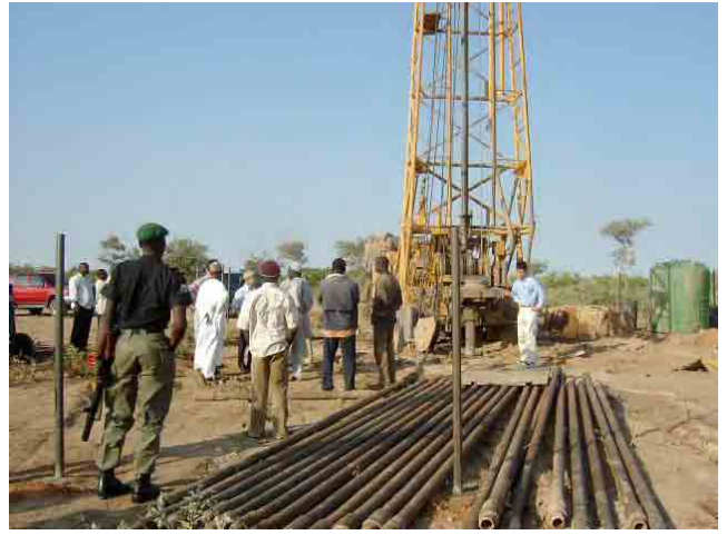
既存ロシア製掘削リグ (1993年製)
